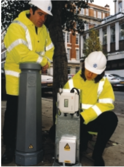
变送器外安装
